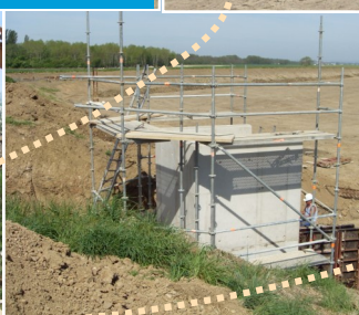
Travaux de maçonnerie
