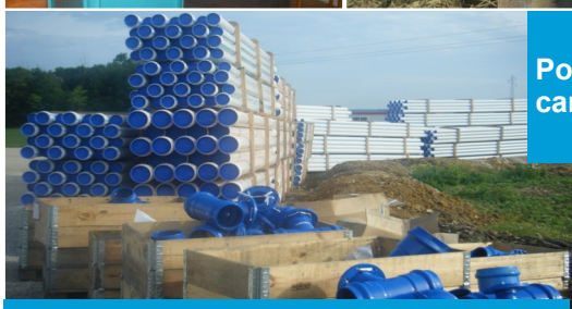
Stockage des canalisations
