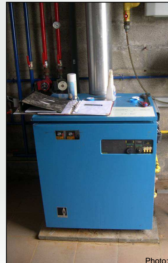
Chaudière biogaz
