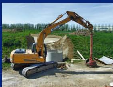
Chantier de réhabilitation des bassins de décantation de la sucrerie
